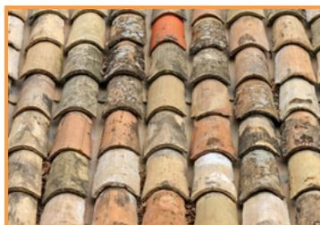
seules des tuiles « tiges de botte » de terre cuite sont admises, avec courants demi-ronds et chapeaux anciens de récupération ou, s'ils sont neufs, de tons mêlés, avec pose brouillée. Les faitages, rives, arêtières et égouts sont réalisés de manière traditionnelle au moyen de tuiles demi-rondes scellées au mortier de chaux.
