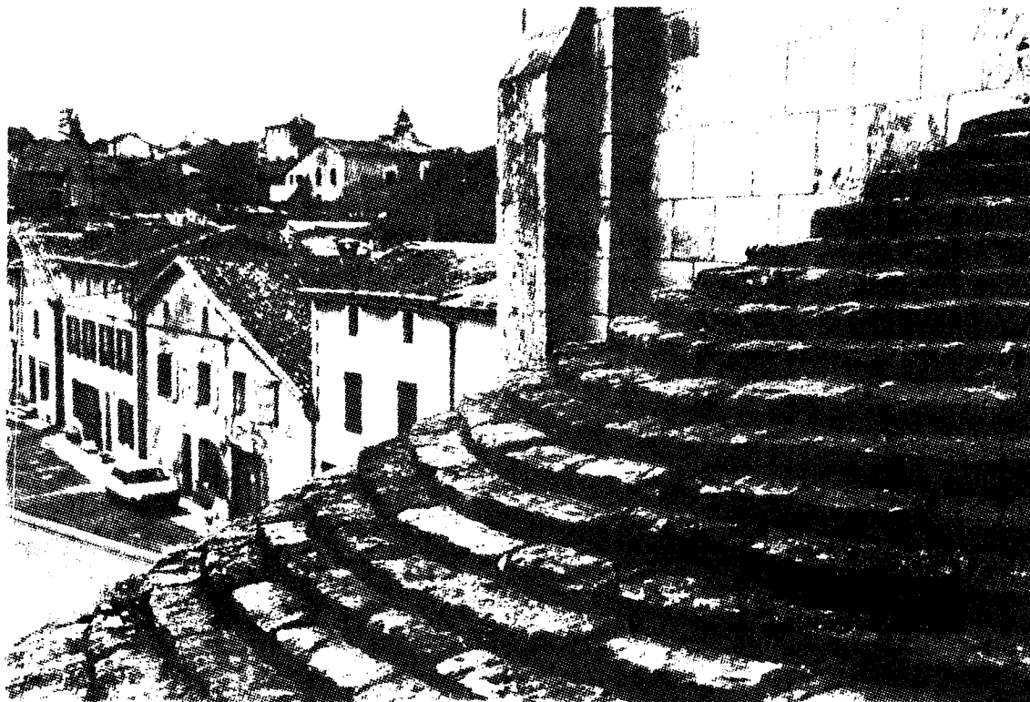
Détail de la pose des lauzes avant les travaux, provoquant des infiltrations.
